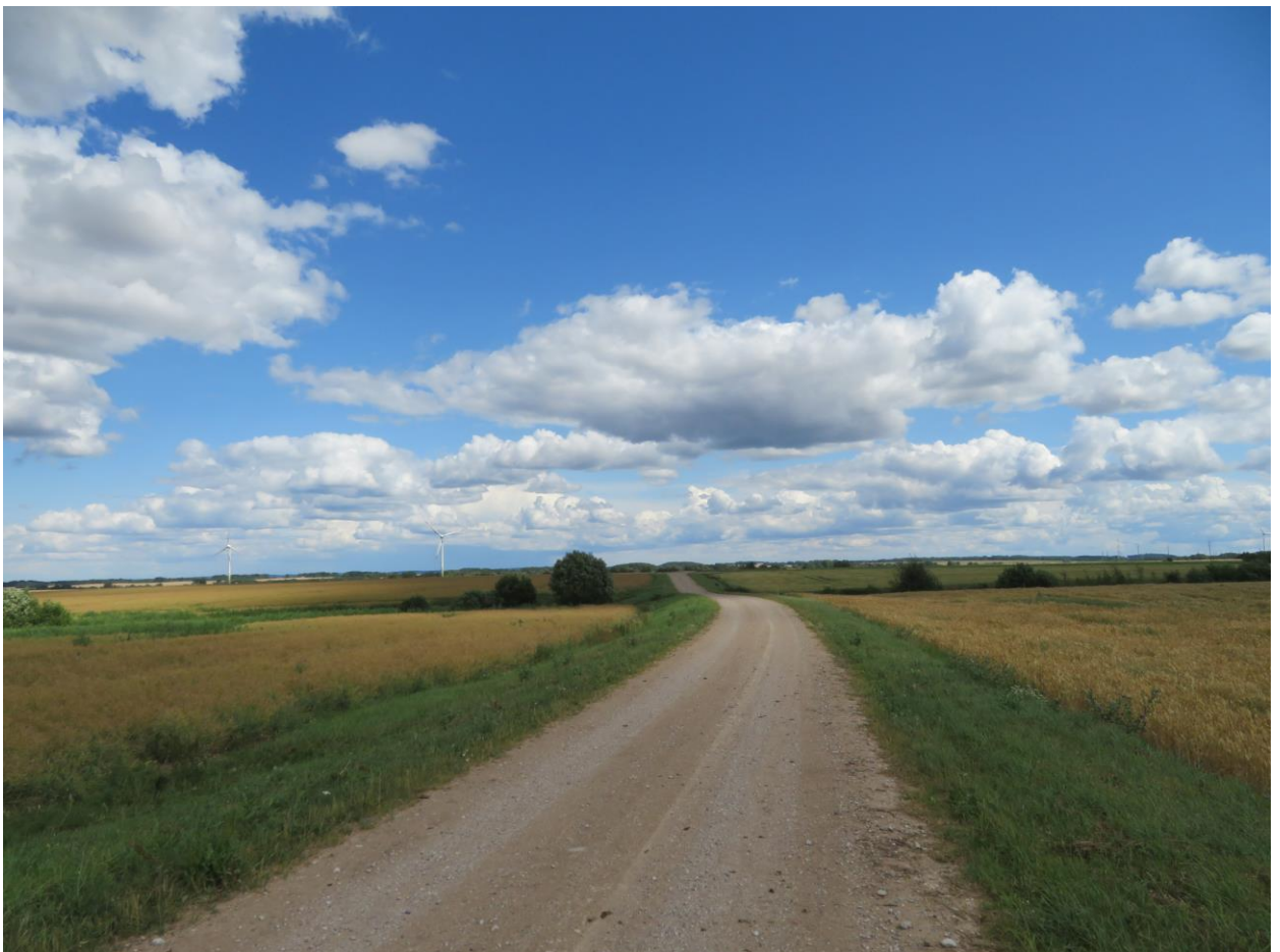
4.1 pav. Greta kelio numatomos vienos elektrinės vieta (antra alternatyva)
